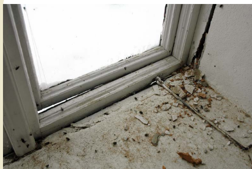
okna před rekonstrukcí
