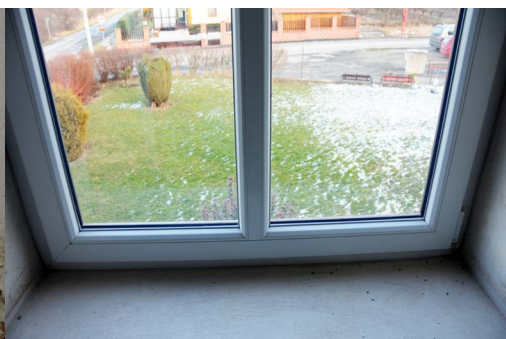
okna po rekonstrukci
