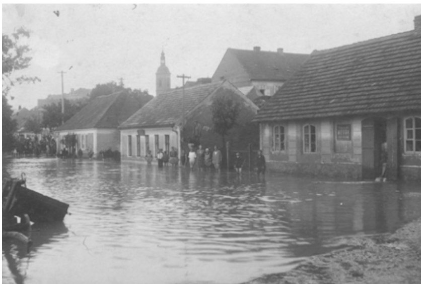
Zatrubnění potoka pod zem pomohlo obyvatelům této ulice před opakováním podobné záplavy v budoucnosti
