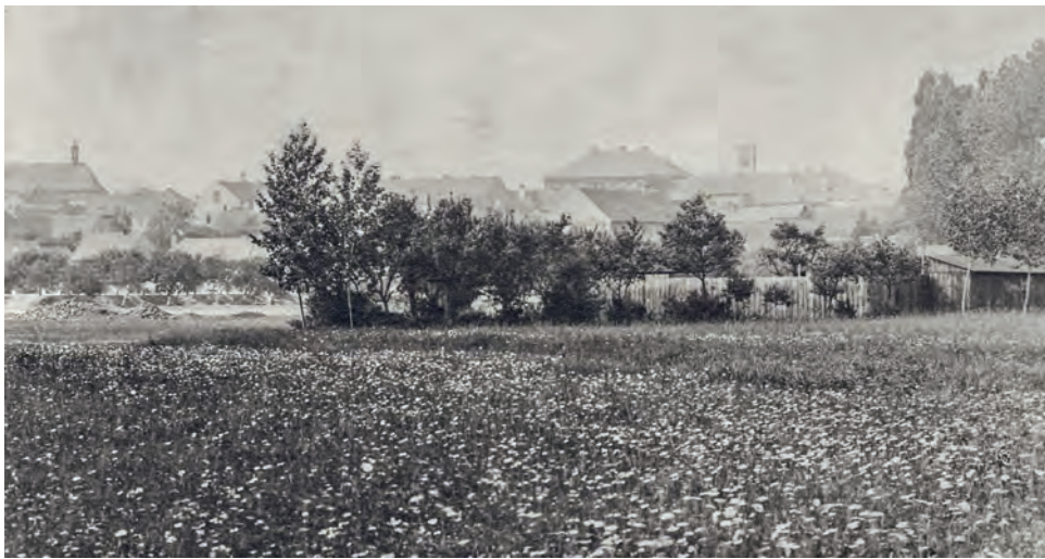
Podmáčené dno starého rybníka už bylo na začátku 20. století loukou. Na části plochy pak vyrostlo hřiště fotbalového klubu Meteor a ještě později ragbyového klubu
