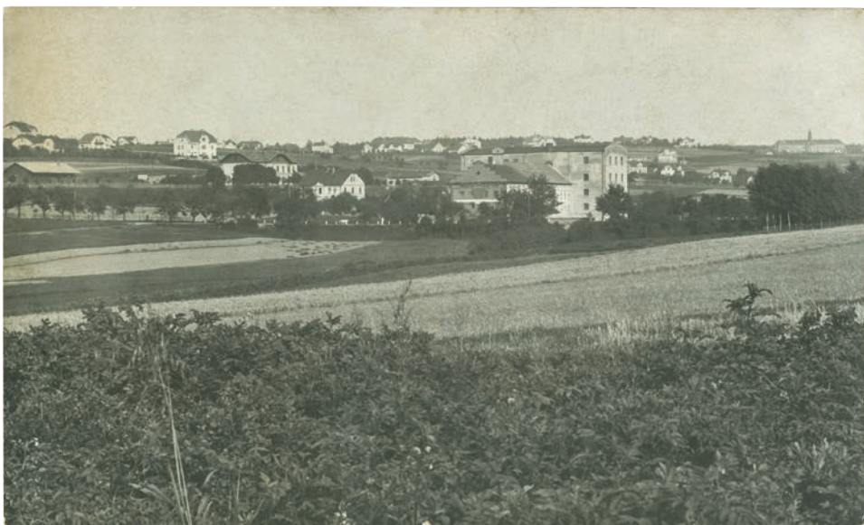
Silnice lemovaná stromy (dnes ul. 17. listopadu) vede v místě někdejší hráze rybníka Bezděkov. V pozadí je vidět, zcela mimo zástavbu, budova Olivovny
