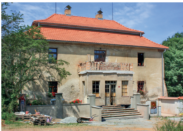
Zámeček v průběhu rekonstrukce
